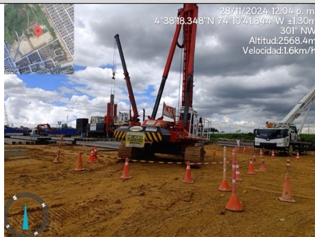
Fotografía No. 1: Actividades de prebarrenado en proyecto centro de alto rendimiento
