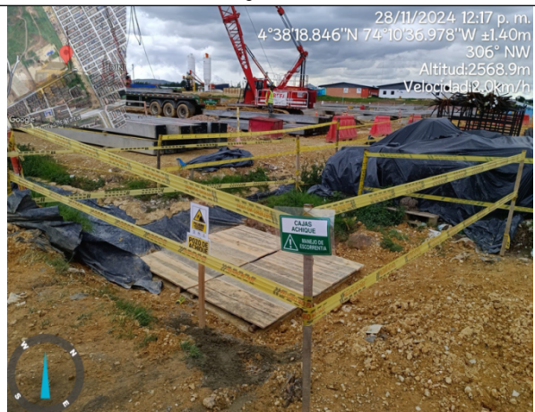
Fotografía No. 4: Cajas de achique para recolección de aguas por escorrentía
