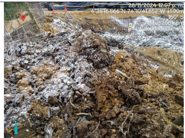
Fotografía No. 3: Aplicación de cal en zona de excavación
